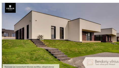
Namuose jau sumontuoti kabinai, šiluminiai, rekuperatoriai
