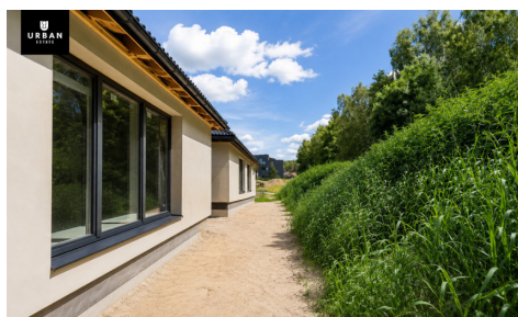
statybų eiga birželio mėn.
