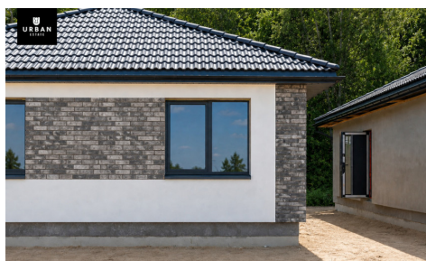
statybų eiga birželio mėn.
