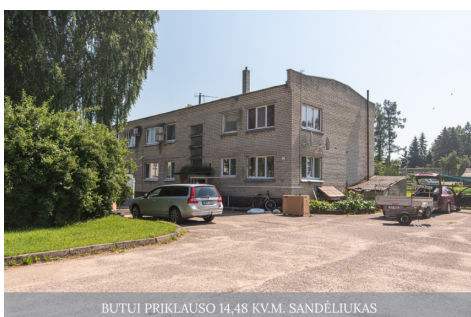
BUTUI PRIKLAUSO 14,48 KV.M. SANDĖLIUKAS
