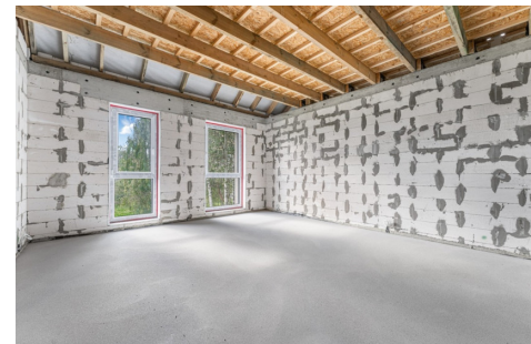
Antrame aukšte išvedžiotas grindinis šildymas, išbetonuotos grindys
