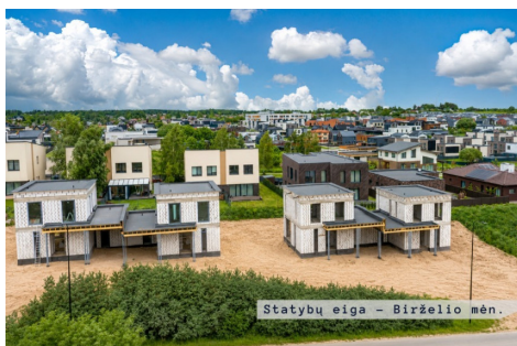
Statybų eiga - Birželio mėn.
