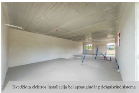
Išvedžioti laidai kondicionieriui
