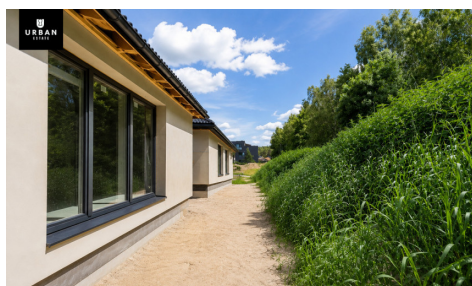
statybų eiga birželio mėn.
