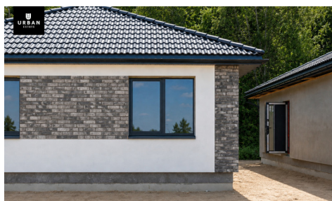
statybų eiga birželio mėn.
