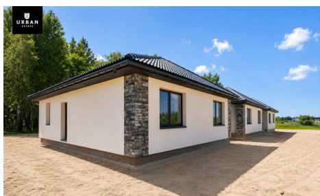
statybų eiga birželio mėn.
