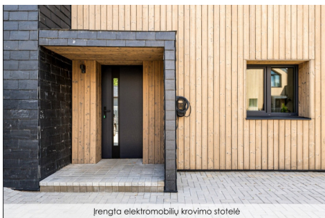
Įrengta elektromobilių krovimo stotelė
