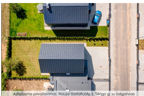
Asfaltuotas privažiavimas. Naujai išasfaltuota S. Šilingo g. su šaligatvis
