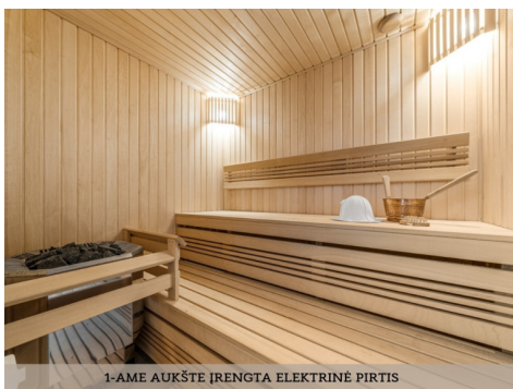
1-AME AUKŠTE ĮRENGTA ELEKTRINĖ PIRTIS
